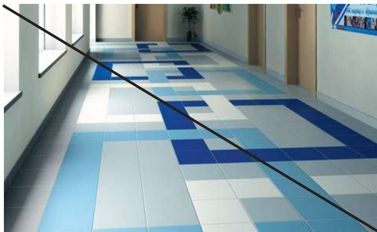
Плохо Цветные вставки из плитки
