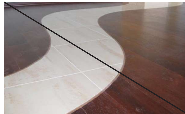
Плохо Узорные стыки из разных материалов
