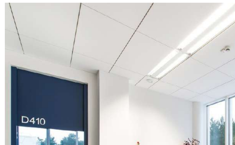
Подвесной плиточный потолок со скрытыми направляющими. Желательно использовать прямоугольные, а не квадратные плиты с наименьшим количеством вкраплений
